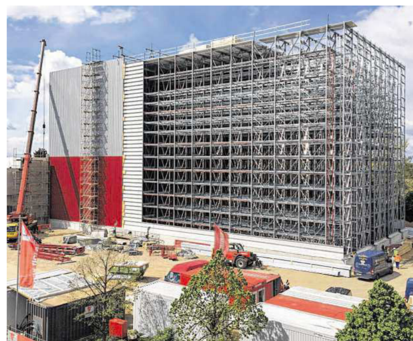
Hochregallager im Gewerbegebiet Wassenberg-Forst: Auf 1650 Quadratmetern entsteht ein 30 Meter hohes Logistikzentrum.
